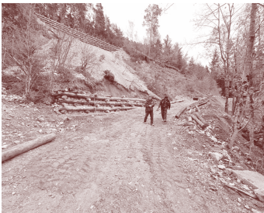
Gradnja dvostenske lesene kašte za podporo nestabilne brežine
